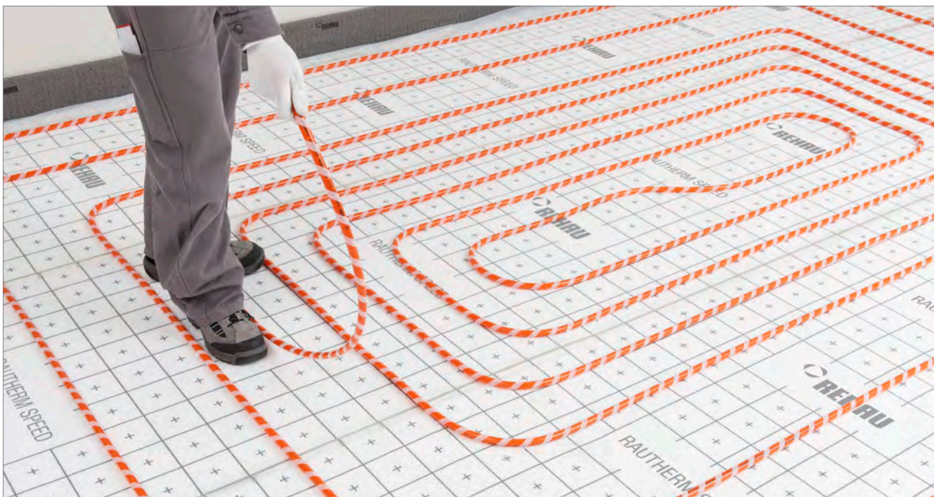
RAUTHERM SPEED pokládka potrubí na pokládací desku
