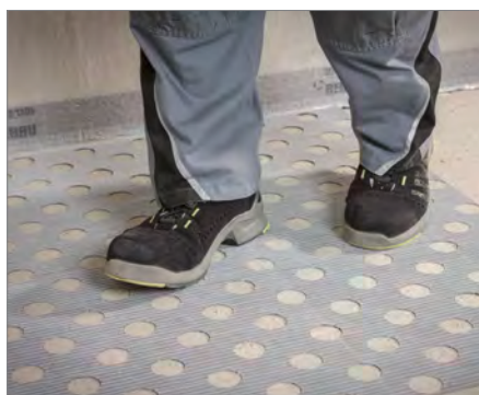
7. Na celé ploše přitlačte na podklad
