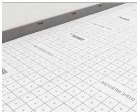
4. Připravená pokládací deska pro pokládku
