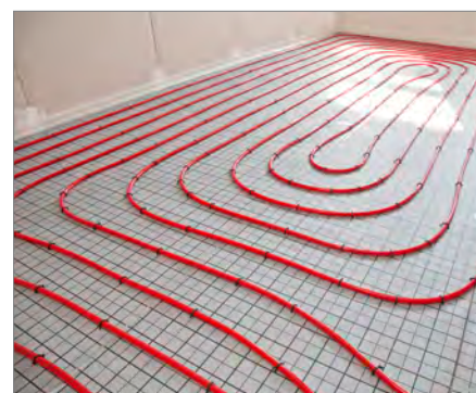
6. Hotová pokládka podlahového vytápění REHAU
