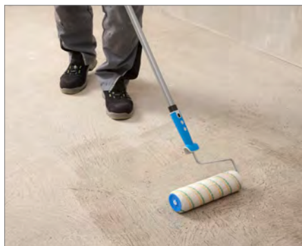
1. Natření podkladu vhodnou penetrací
