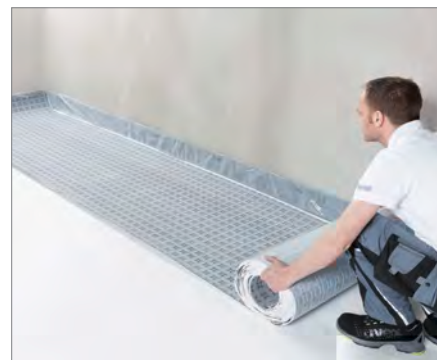
2b. Postupné přilepení rohože - role
