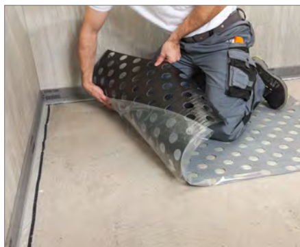
4. Ze spodní části odlepte ochranou folii
