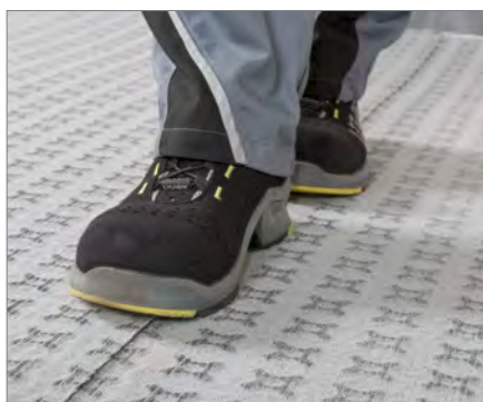
4. Přitlačte pevně přesahy rohože
