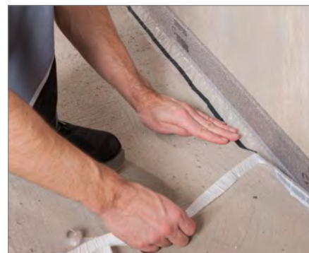
3. Přilepení folie patky dilatační pásky
