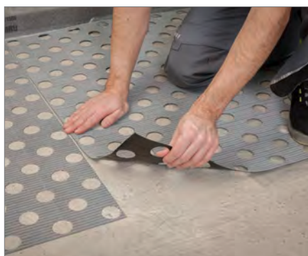
8. Další rohož přilepte bez překrytí
