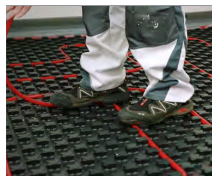
3. Pokládka trubky RAUTHERM S
