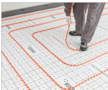
6c. Pokládka trubky RAUTHERM SPEED K
