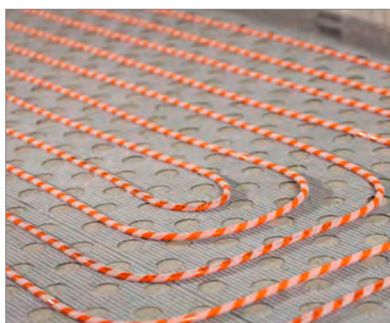
11. Hotová pokládka, proveďte tlakovou zkoušku
