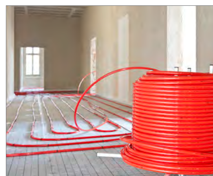
3. Pokládka trubky z odvíjecího zařízení
