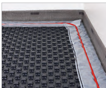
2. Pokládka trubky RAUTHERM S u stěny
