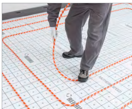
6b. Pokládka trubky RAUTHERM SPEED K
