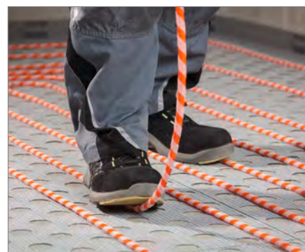
9. Pokládka trubky RAUTHERM SPEED K 10
