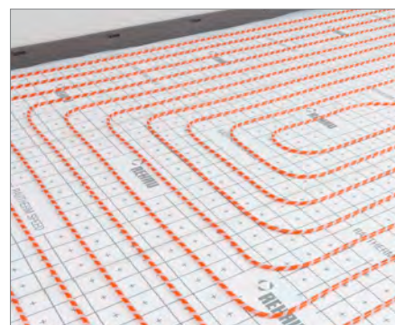
7. Hotová pokládka, proveďte tlakovou zkoušku
