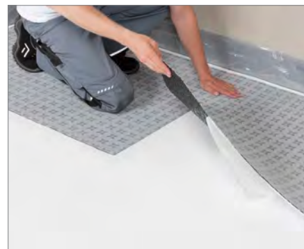
2a. Postupné přilepení rohože - deska
