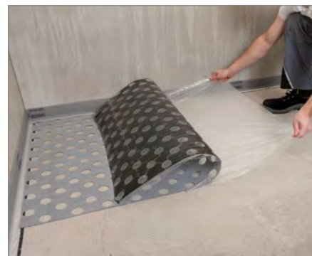
6. Odstraňte zbytek ochranné folie
