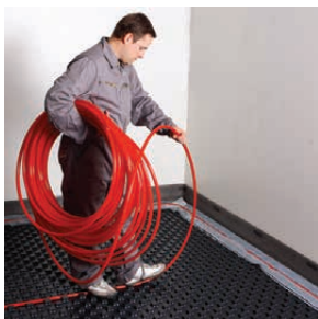
9. Pokládka trubky RAUTHERM S.
