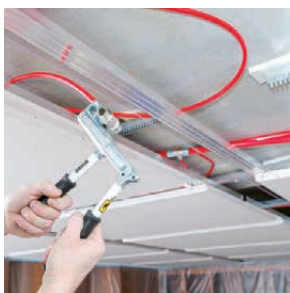
Montáž přípojovacího potrubí
