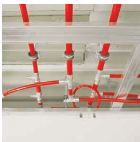
Přípojovací potrubí Tichelmann
