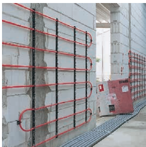
Systém Raufix 14 - jednoduchý meandr
