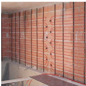
Systém Raufix 14 - dvojitý meandr
