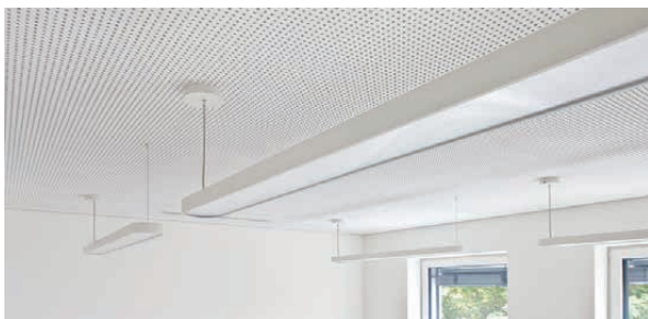
Hotový akustický strop
