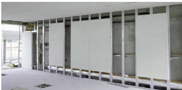
Stěnové vytápění/chlazení - suchý způsob
