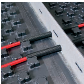
Přechod přes dilatační profil
