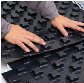
5. Instalace systémové desky na podklad.
