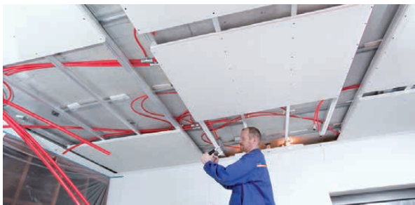
Stropní vytápění/chlazení - suchý způsob
