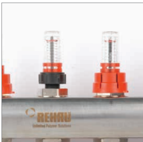
2. Otevření okruhu otáčením černé matice směrem doleva
