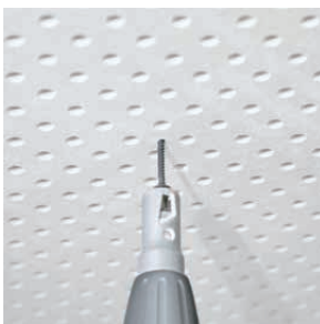
Předvrtaný montážní rastr z pohledové strany desky pro upevnění desek.
