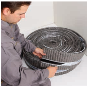
1. Oddělení ochranné pásky lepidla dilatační pásky.
