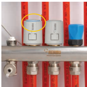
3. Na adaptér nacvakneme termopohon.
