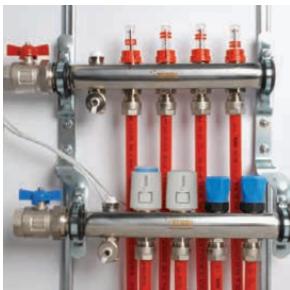
12. Napojení na REHAU rozdělovač HKV-D nerez s regulací.
