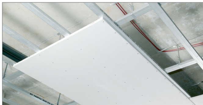
Obr. 5-5 Namontovaná stropní deska
