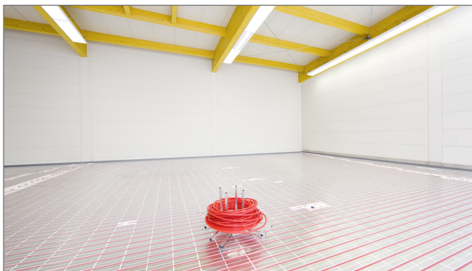
Obr. 13-1 Suchý systém s plošně elastickou sportovní podlahou
