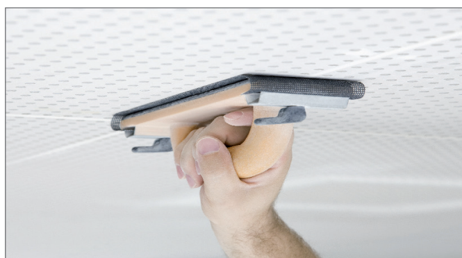
Obr. 4-27 Přebroušení povrchu
