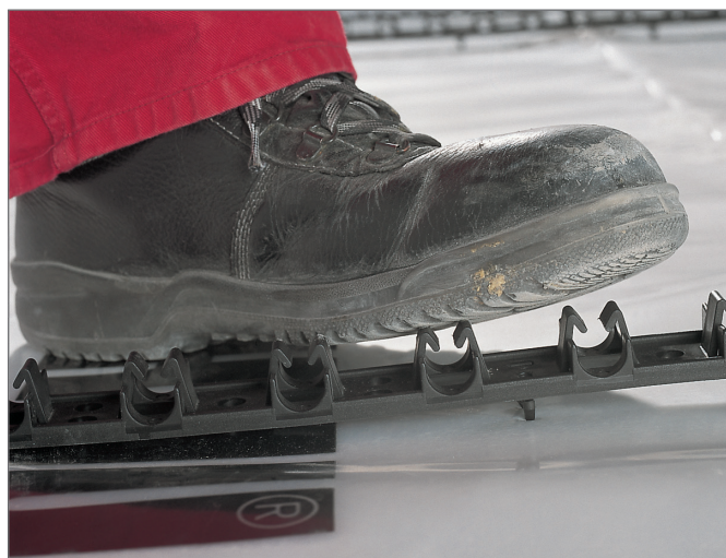
Obr. 3-49 Zatlačte vodící lištu RAUFIX do podlahové konstrukce
