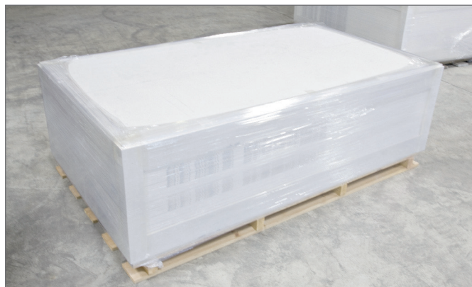
Obr. 4-11 Dodání a skladování desek akustického chladicího stropu
