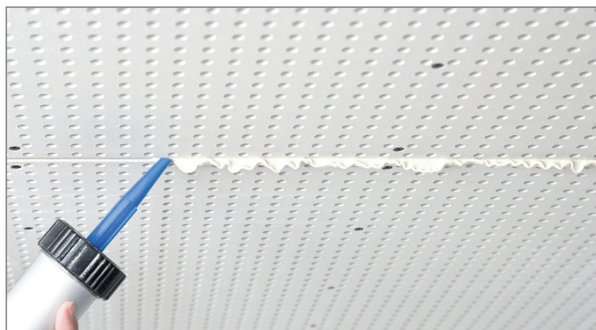
Obr. 4-24 Úplné vyplnění spáry po celé tloušťce desky 20 mm
