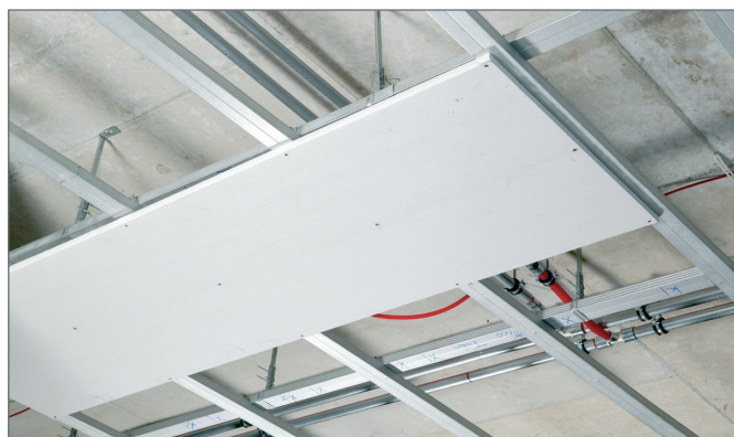
Obr. 7-24 Namontovaná stěnová deska na stropě
