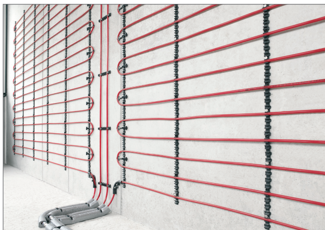
Obr. 7-1 Stěnové vytápění / chlazení - mokrý způsob
