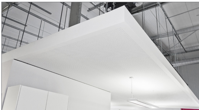
Obr. 4-8 Příklad provedení volně zavěšené stropní desky
