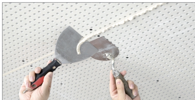
Obr. 4-25 Odstranění vytvrzené tmelící hmoty
