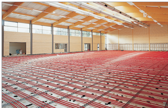
Obr. 14-7 Systém trubkového rozdělovače SBH
