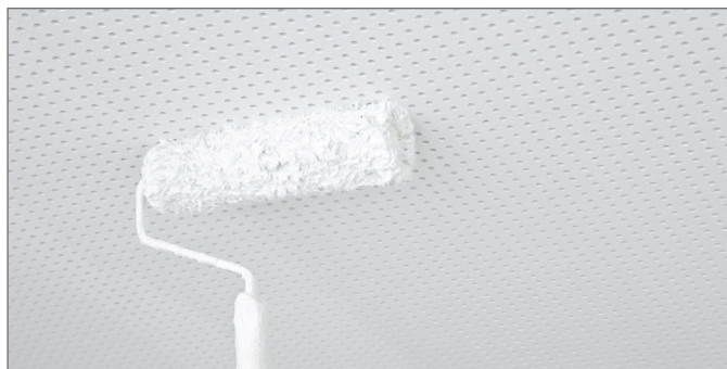
Obr. 4-28 Nanesení barvy válečkem
