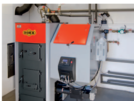
Vzorová kotelna s kotlem ROJEK TKA 25
