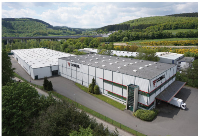
Závod 2 Výrobní hala s logistickým centrem
