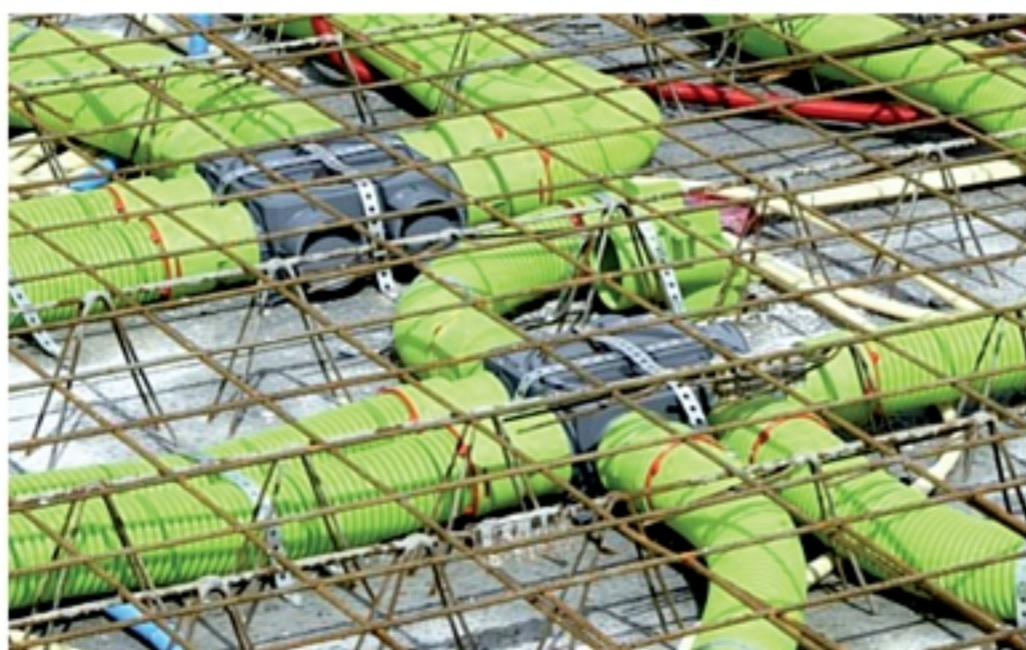
Instalace rozvodu do betonových monolitů
