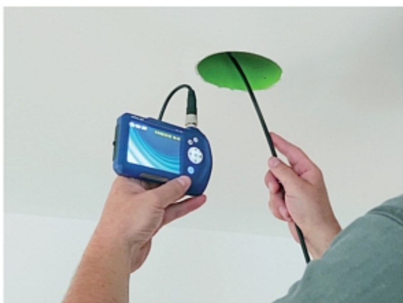
Kontrola čistoty koncových tvarovek a potrubí.
