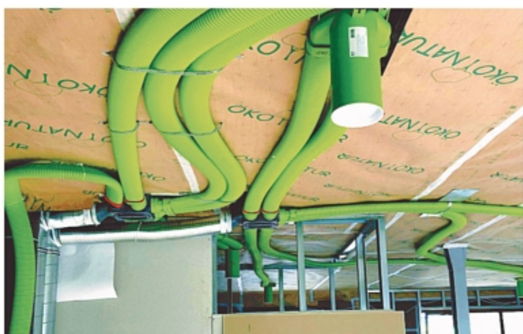
Instalace rozvodu do stropu, nízký profil = minimální navýšení
