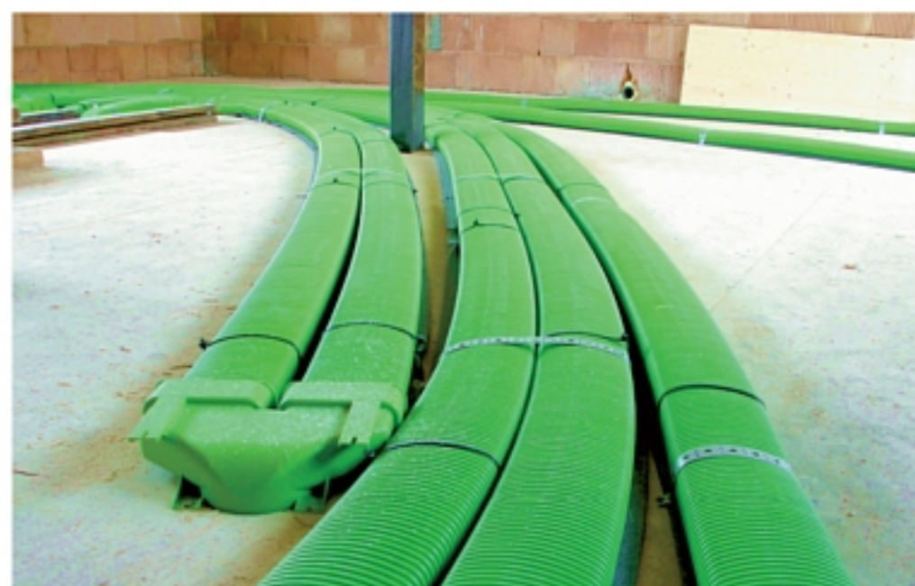
Instalace rozvodů v podlaze
