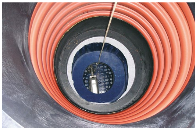
Pohled do šachtové roury Tegra 600 s šachtovým adaptérem na boxu Q-Bic
