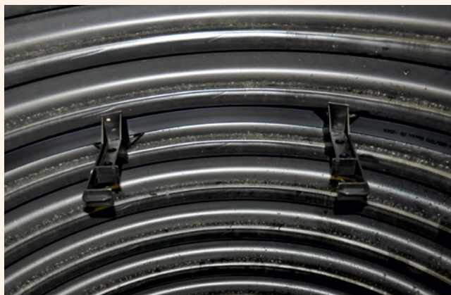
Předpříprava obruče žebříku v šachtové trubce
